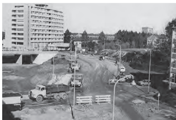
Werkzaamheden Asingastraat in 1974 Foto: De Groningse Fotodoos
